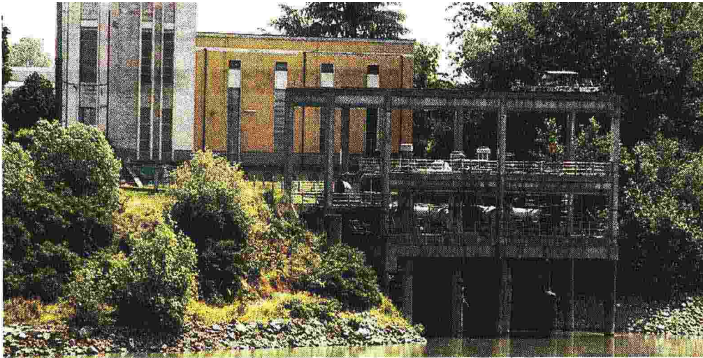
Uno degli impianti gestiti dal consorzio di bonifica Navarolo
