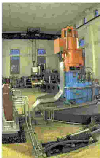
La centrale idroelettrica di Bassano
