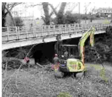
I lavori sul torrente Arzilla
