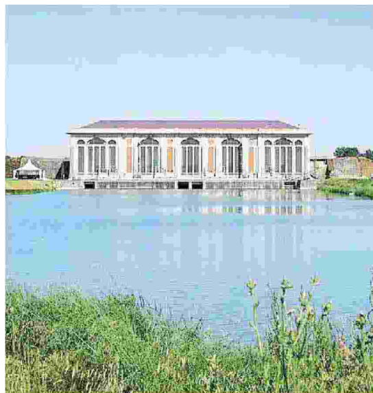
L'impianto idrovoro delle Pilastresi a Stellata
