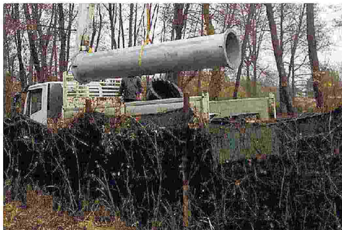
I lavori per potenziare l'impianto idrovoro sul viale Apua
