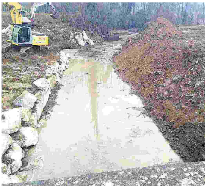
I lavori sul Rio Leccio
