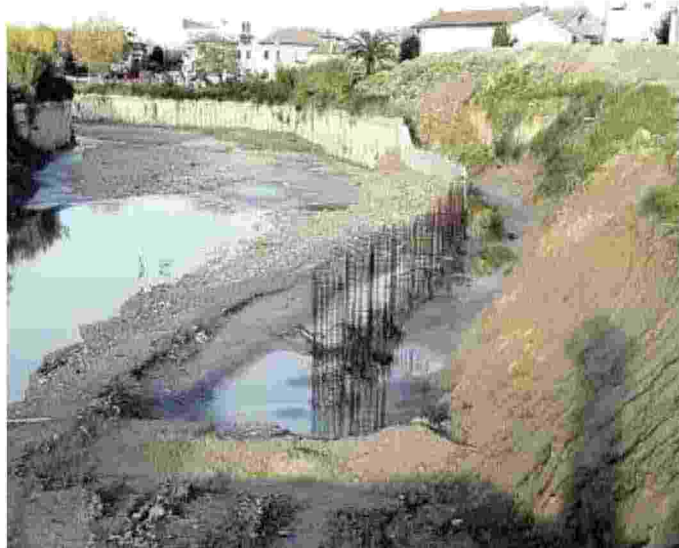
Una fase dei lavori per la messa in sicurezza del fiume
