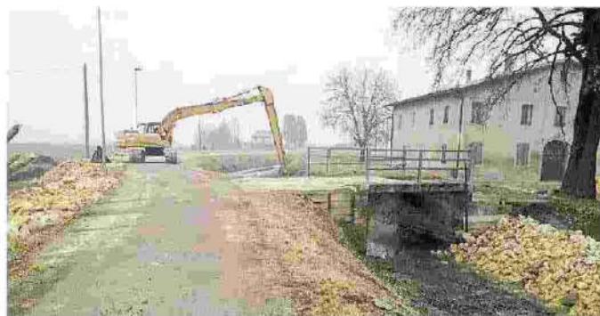
Interventi di consolidamento sulle sponde di un canale di bonifica
