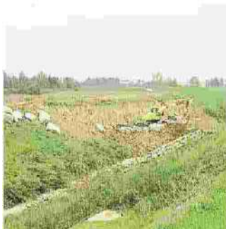
Lavori sull'argine dello Stella
