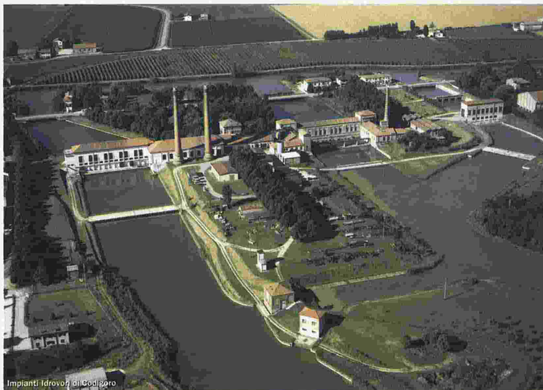
Impianti Idrovori di Codigoro
