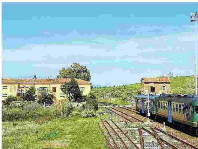
La vecchia stazione di Fraigas
