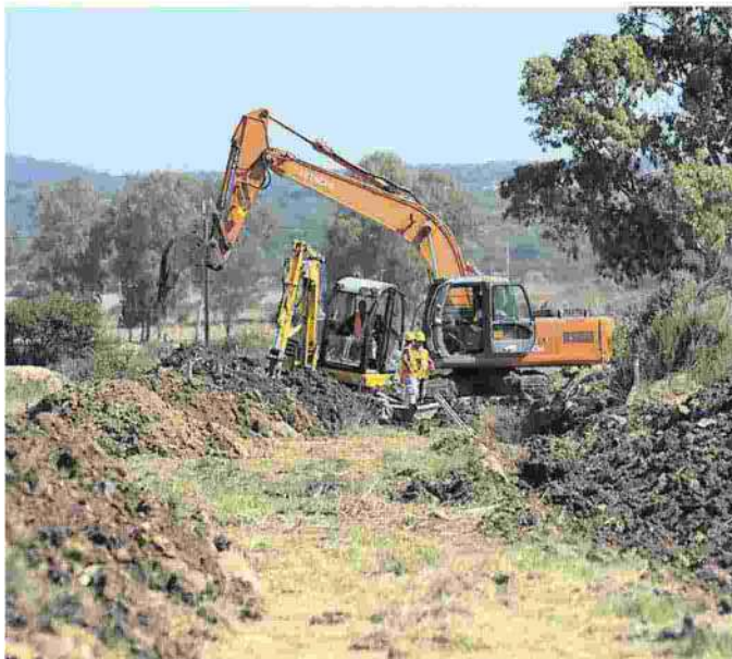
Lavori di Abbanoa per l'acquedotto
