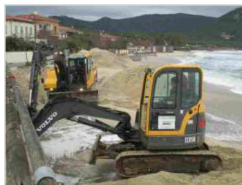
Un intervento dei mezzi del Consorzio di Bonifica
