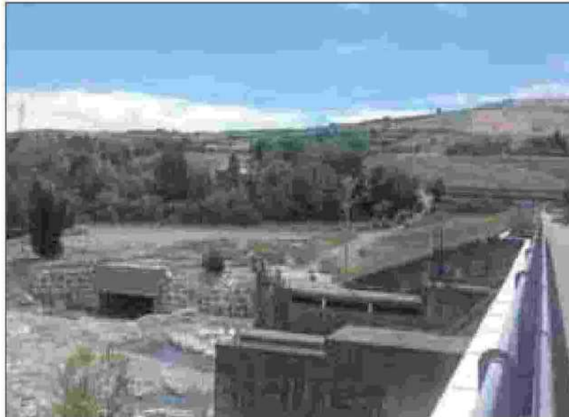
Impianto idroelettrico di Iren Rinnovabili a Castellarano
