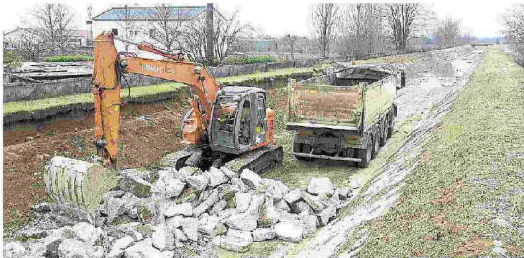
L'intervento sul canale di Ponente a Bavaria di Nervesa che prevede la demolizione delle vecchie sponde deteriorate
