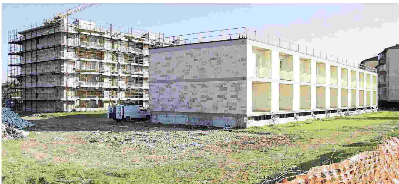
Le villette a schiera e gli appartamenti che il Consorzio Acli sta terminando al Varignano
