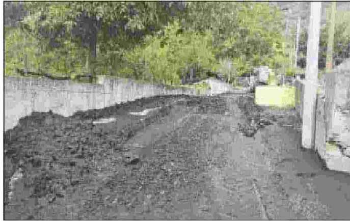
Nella foto l'inizio dei lavori a ridosso del Monte Salto
