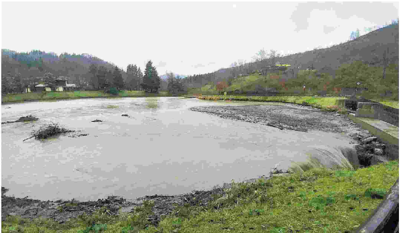
Ecco come si presenta oggi il lago Fiorenzo dopo la rottura di un argine
