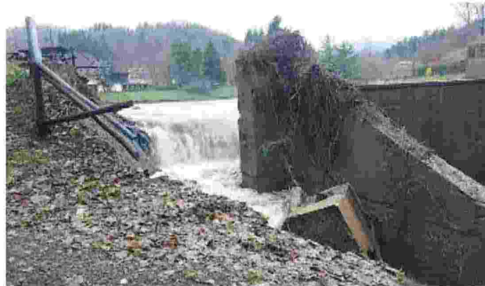
Con l'argine sfondato per il maltempo, lo specchio d'acqua è ormai vuoto
