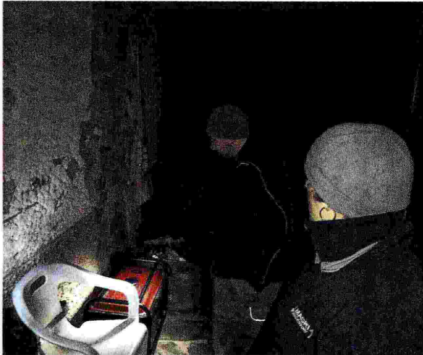
Intervento Volontari del Nip (Nuovo intergruppo Parma di protezione civile) installano un generatore.
