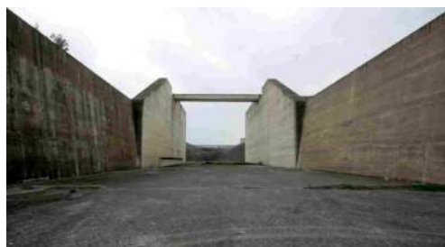
Diga di Pietrarossa
