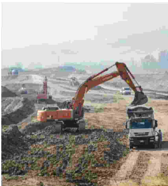
I lavori per la realizzazione dell'imponente opera
