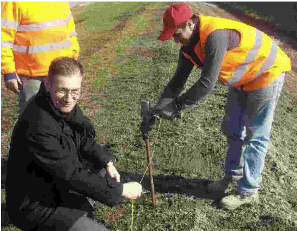
Il sindaco Attilio Gastaldello dà il via ai lavori per la pista ciclabile delle Risorgive
