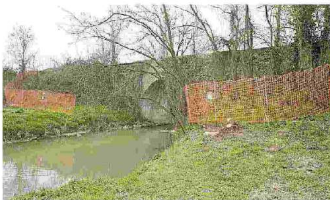
La nuova recinzione installata dal Consorzio Garda Chiese (foto Saccani)
