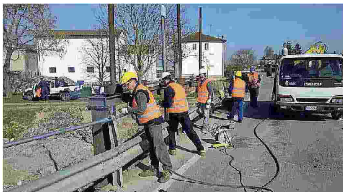
Operai al lavoro sulle paratoie del canale Gherardo
