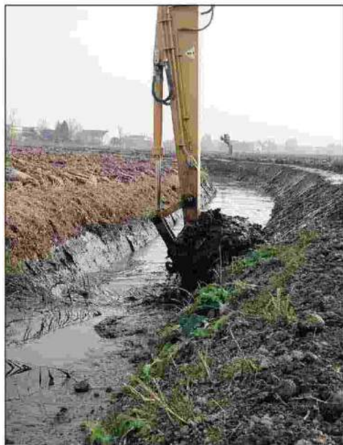
L'intervento effettuato nel fossato
