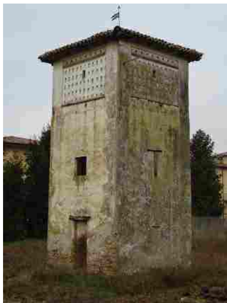
Edificio rurale a Longhena
