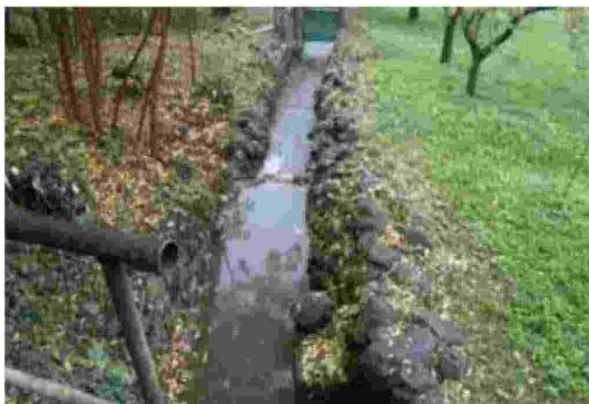
Consolidato anche il percorso della roggia Scola
