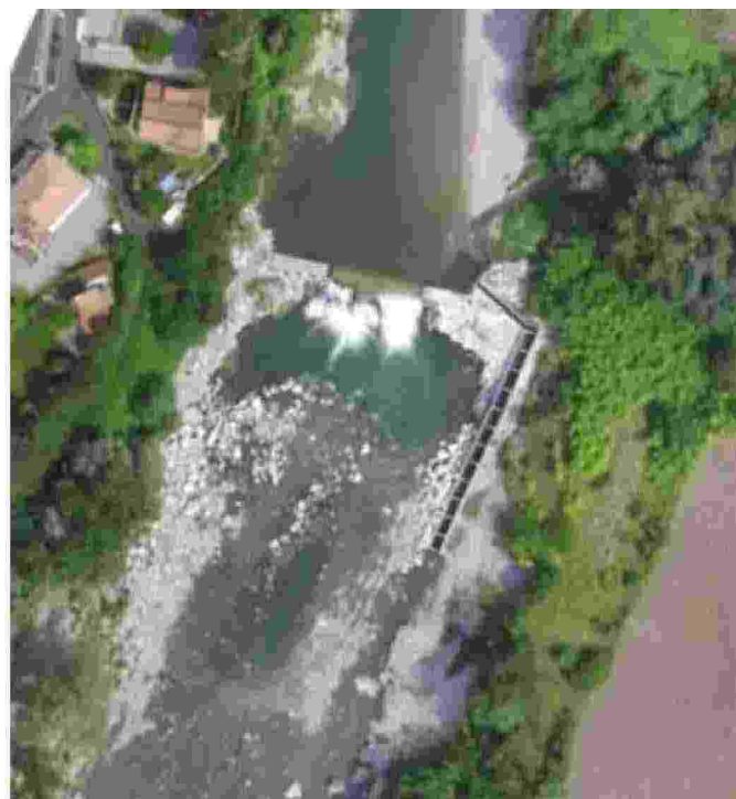
RISCHIO IDROGEOLOGICO Di fianco la briglia e a destra la risalita per i pesci danneggiate dalle piene del Brembo. Sopra la località vista dall'alto
