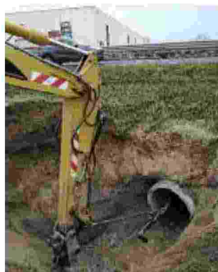
Una fase dei lavori
