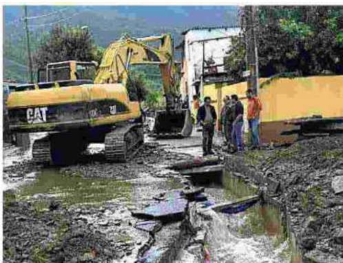
Ingenti danni a Torpè nell'alluvione del novembre 2013
