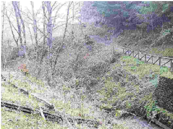
L'area dell'intervento del Consorzio
