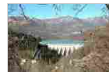
Diga del Brugneto (GE)
