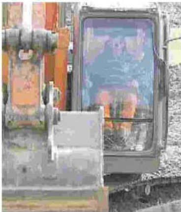
Un operatore alle prese con il ripristino di un argine
