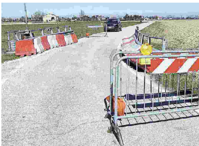
Il ponticello in zona Casematte a Ostellato
