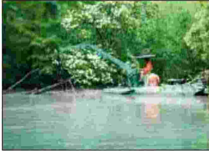
LAGHETTO I lavori nello stagno del bosco
