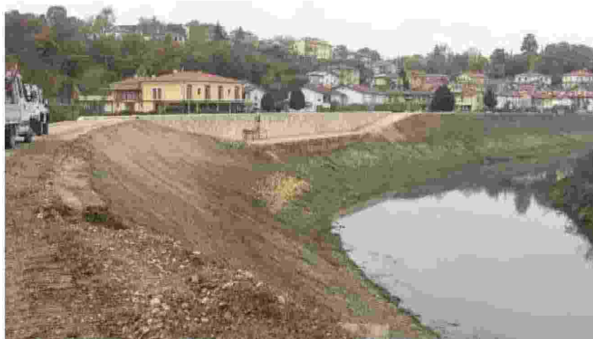
L'argine del Bacchiglione dopo l'intervento di protezione dalle piene. ZORDAN
