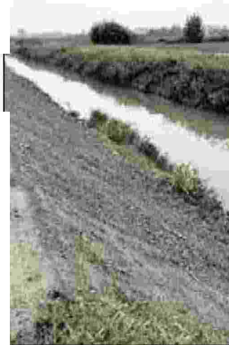
VIA TRIESTE Ripristino effettuato
