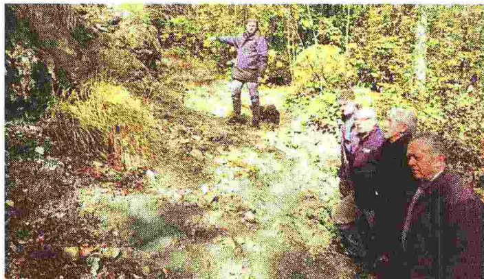
GROPPARELLO - Il sopralluogo dei tecnici per la frana che minaccia le case di Carini
