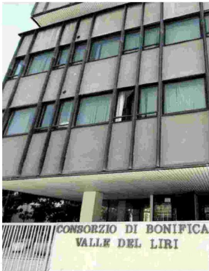
La sede del Consorzio di Bonifica Valle del Liri
