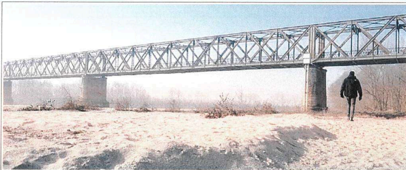
Il Ponte della Becca sul fiume Po
