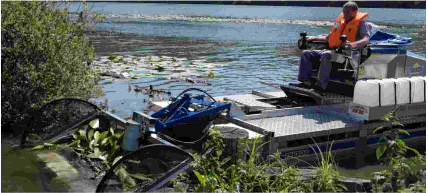
Lavori di sistemazione dell'argine di un fiume
