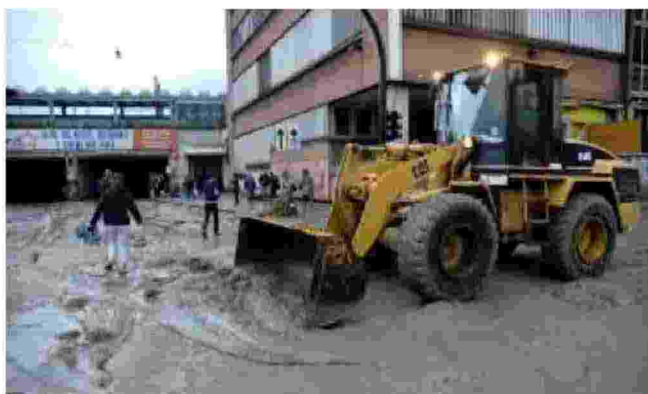
Lavori di ripristino dopo un'alluvione
