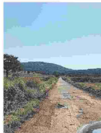
CAGNANO Una delle strade interessate dall'intervento prima e dopo i lavori
