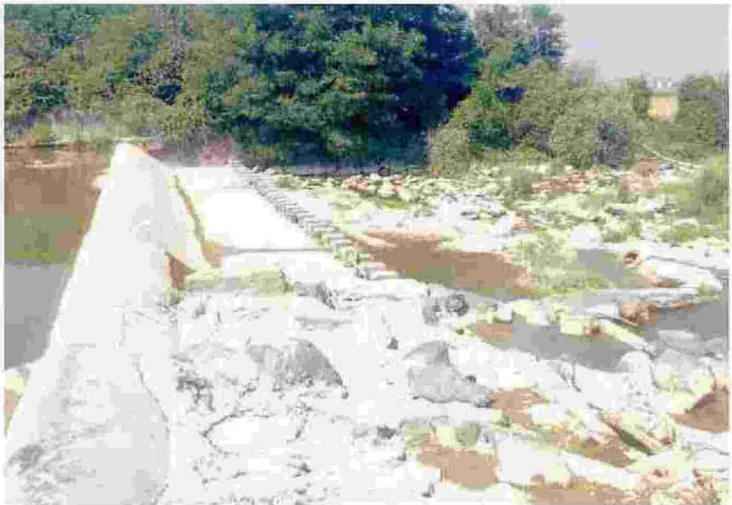
La situazione idrica alla diga del Baluardo, due chilometri a Sud di Racconigi
