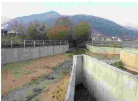
Il canale può convogliare fino a 30 metri cubi d'acqua al secondo
