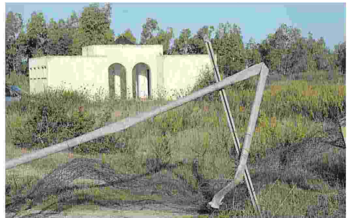
Il cantiere dell'autodromo di Arborea, i lavori sono iniziati 30 anni fa
