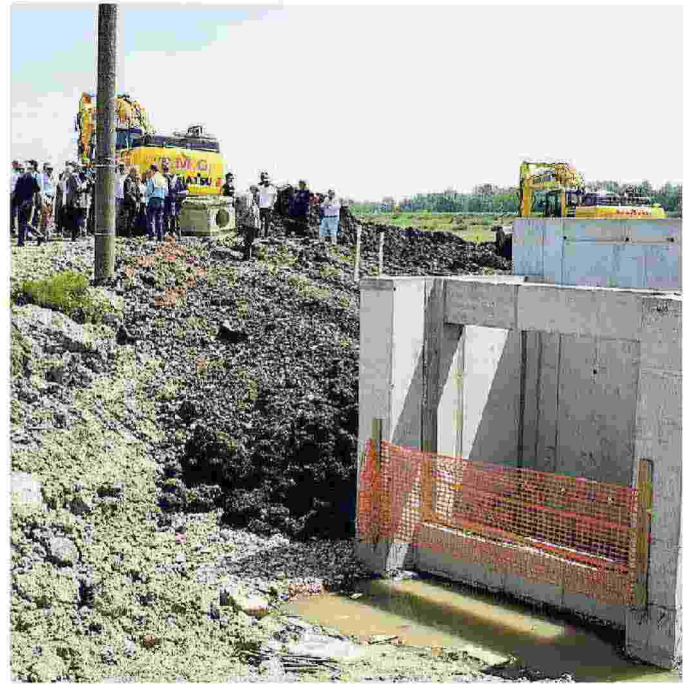
Lavori per la cassa di laminazione a Cento
