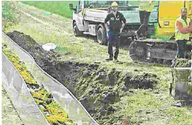
Le operazioni di bonifica del terreno e del canale Desturo in via Vanzo
