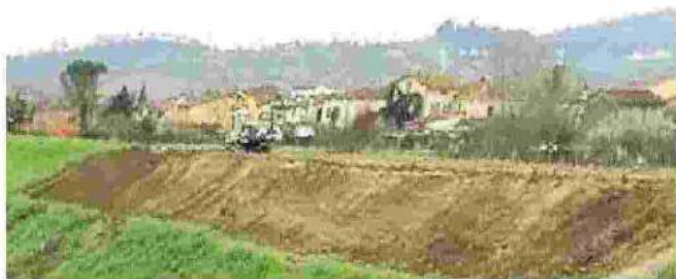
I lavori lungo l'argine del torrente Stella (foto Legambiente)
