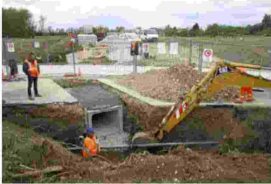
Il posizionamento degli scatolari in cemento. BONATO
