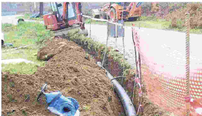
Località Filetto di Villafranca, l'esecuzione di condotte irrigue
