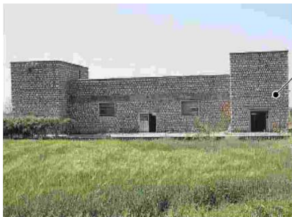
L'impianto di Campo Setino (fonte: sito Consorzio di Bonifica)
