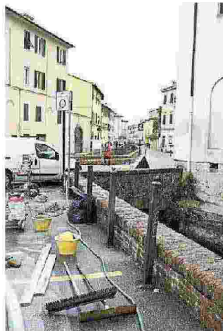
I lavori sul fosso
