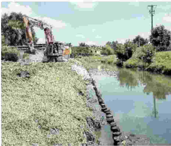
INTERVENTI Operai sul canale Tergola a San Giorgio delle Pertiche
