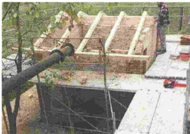
I lavori per dotare San Nicolò di una nuova vasca di laminazione
