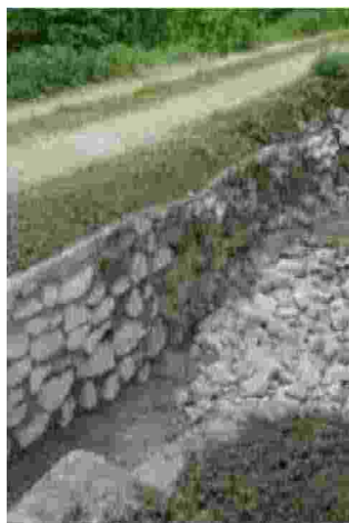
Lavori realizzati in via Ronchi. G.A.R.
