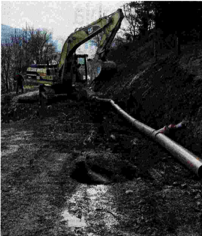
Lavori I ventinove cantieri finanziati riguardano ventun comuni del territorio parmense.
