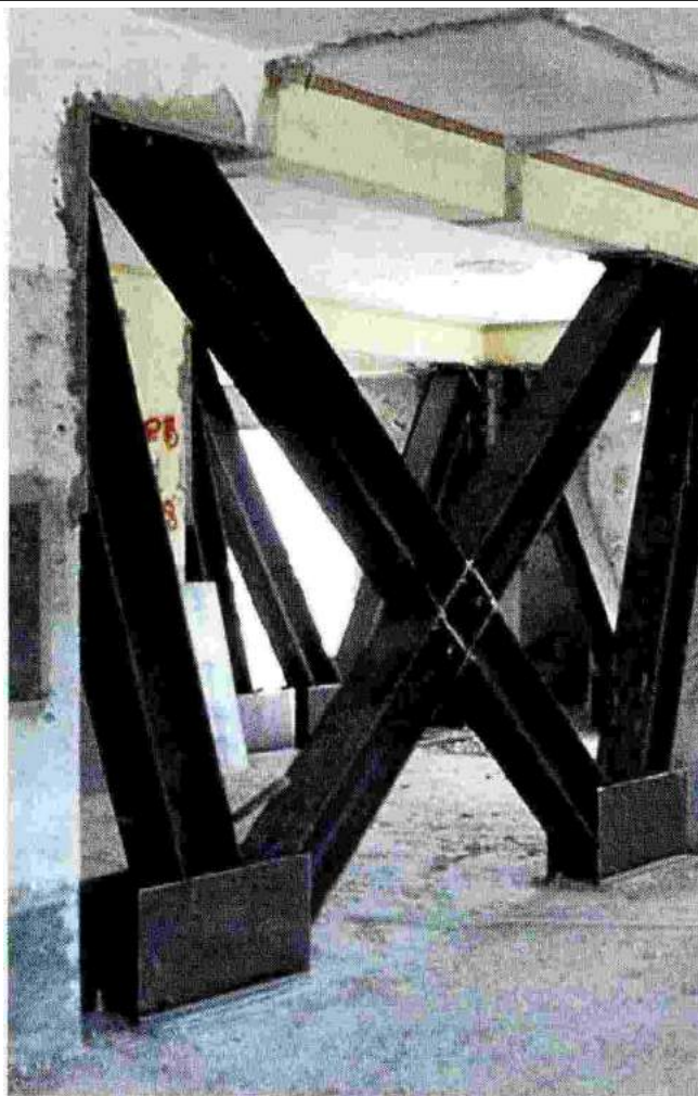
Lavori per la messa in sicurezza sismica di un edificio
