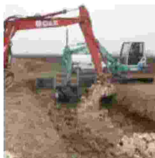
I lavori lungo il Fossiello.L.Z.
