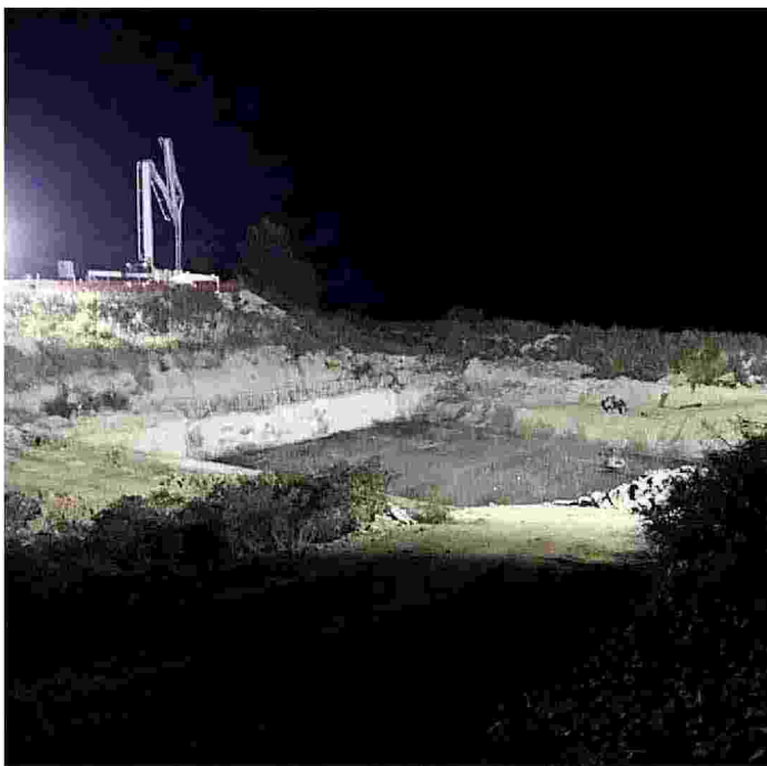
I lavori in corso per la realizzazione della nuova controchiavica
