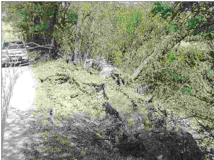
Pista ciclabile I danni provocati dall'ultima tromba d'aria in Casentino. Operai dell'Unione subito al lavoro
