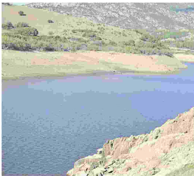
La diga di Maccheronis
