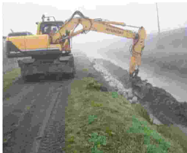
Operai del consorzio al lavoro nella fossetta Feudo, a Bevilacqua
