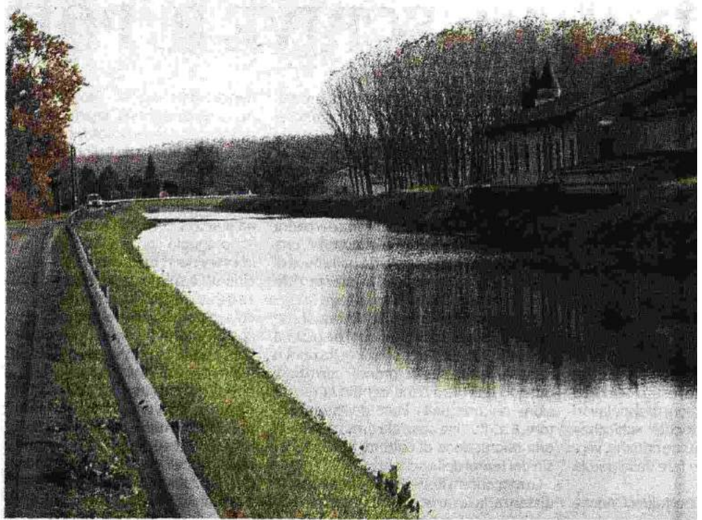
Situazione critica L'attuale pericolo a Bocca d'Enza, nel comune di Mezzani.
