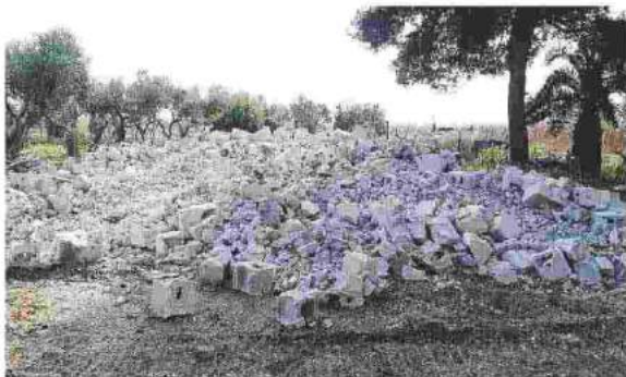
MANFREDONIA I resti della demolizione
