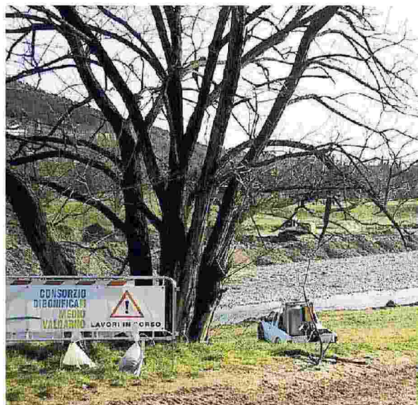
Lavori del Consorzio di Bonifica sul Bisenzio all'altezza del Ponte Datini
