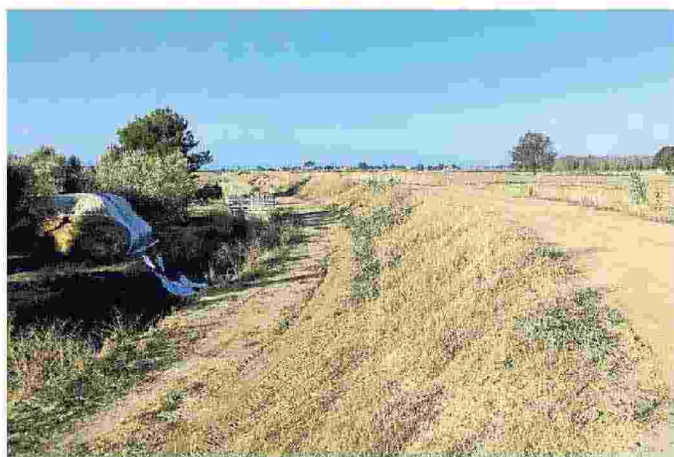
L'argine remoto in località Quarto Albegna
