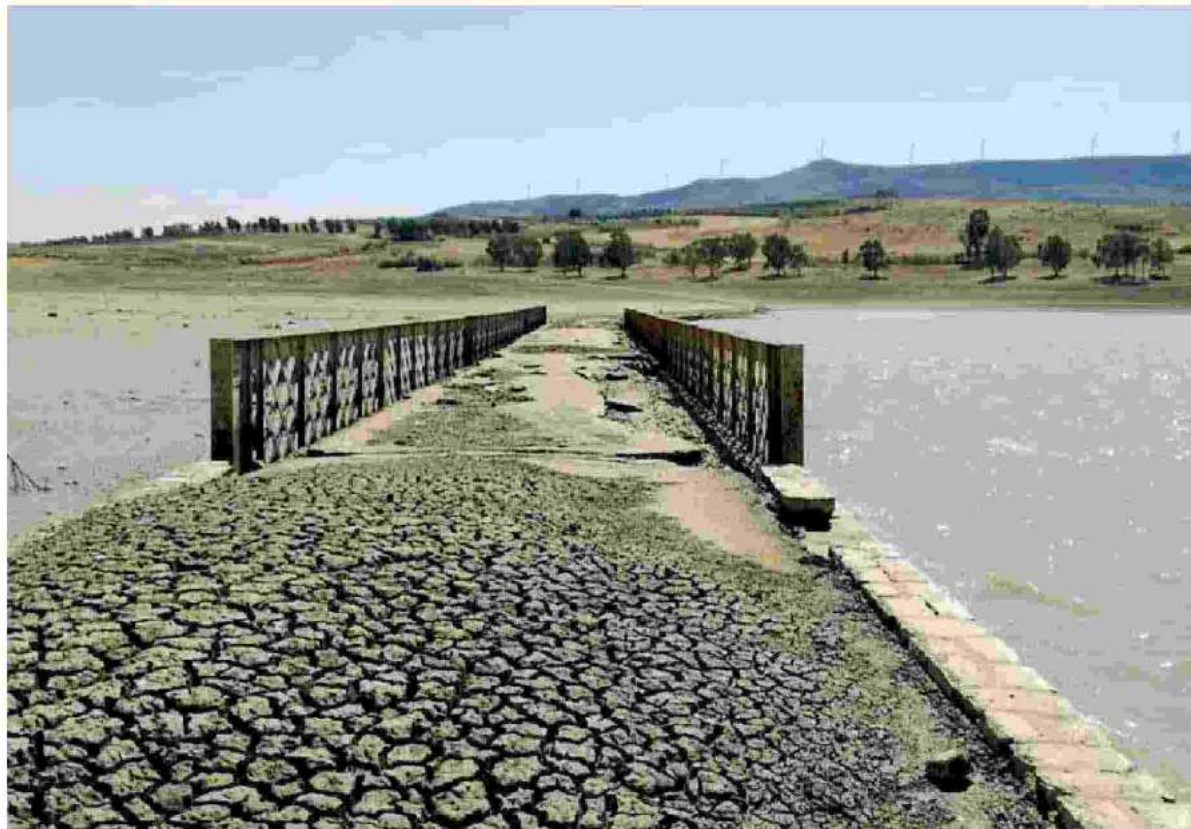
Ponti e vecchie stradelle sono riemersi sulla diga Jato a causa della mancanza di risorse idriche
