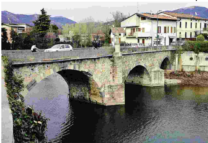
Il cantiere per la passerella ciclopedonale sul fiume Serio partirà entro il primo trimestre 2018
