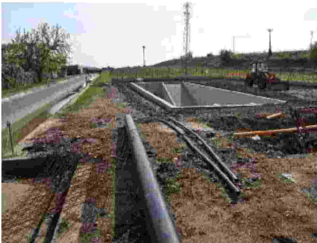
I lavori per la vasca dissabbiatrice. FOTO: PECORA
