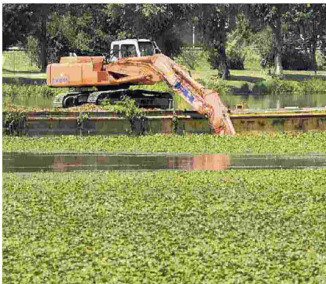
Un'immagine dei lavori di contenimento dei trigoli fatti nel 2016
