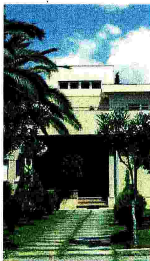
Consorzio di bonifica. La sede del "Cajr"
