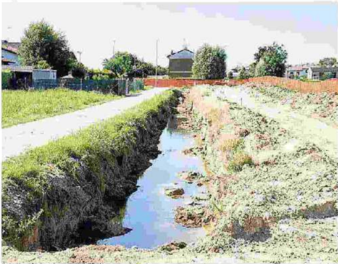
Ora si sta procedendo alla pulizia dei canali all'esterno
