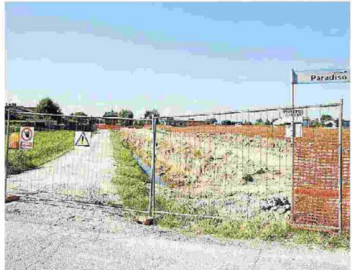
Una veduta del cantiere da strada Paradiso
