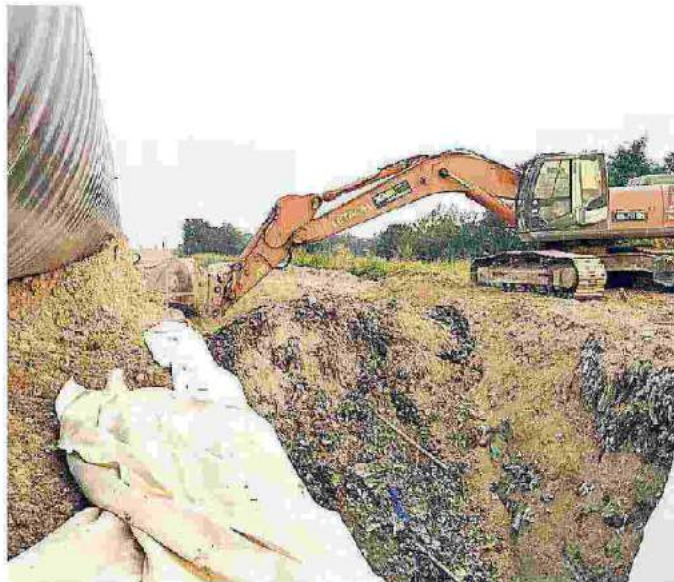
Gli scavi per il metanodotto nel 2014
