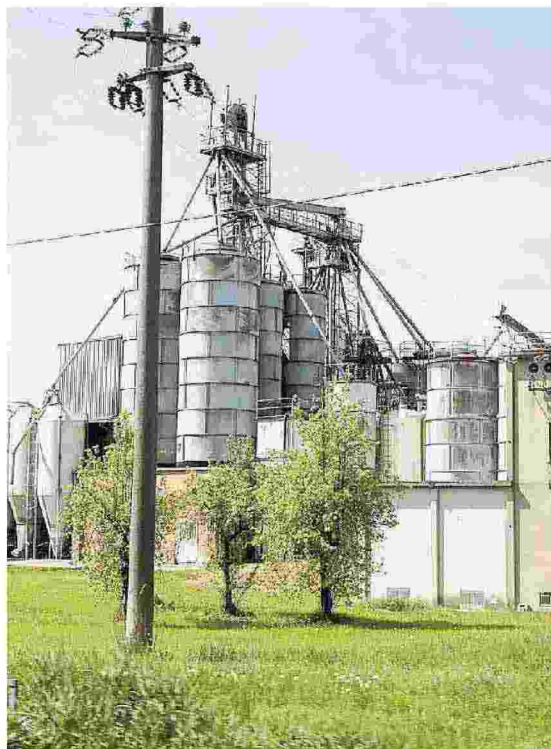
Oltre all'ampliamento dell'allevamento sarà realizzato un impianto a biogas
