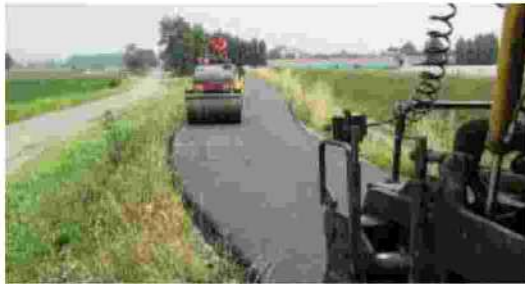
Lavori di asfaltatura della ciclo-pista FOTO AMATO
